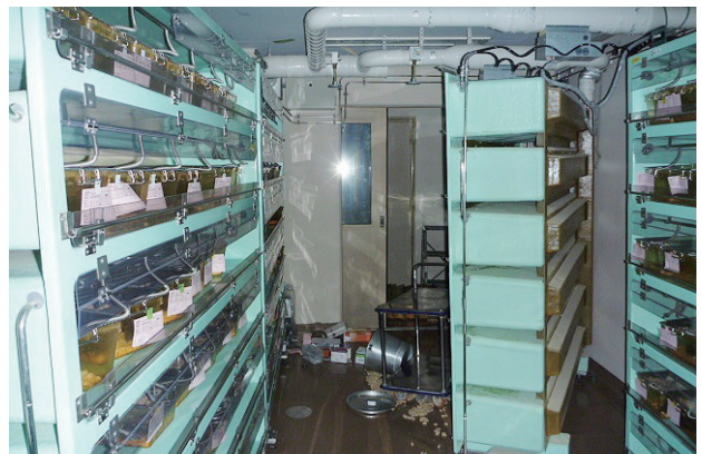
（中央棟）飼育棚も左右壁に金具で固定されていたが、激しく移動していたものの、転倒、ケージ落下はない
