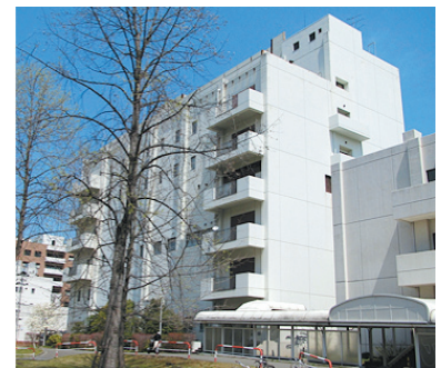
動物実験施設 中央棟
