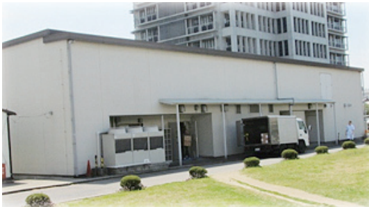
0号館（震災時改修中）
